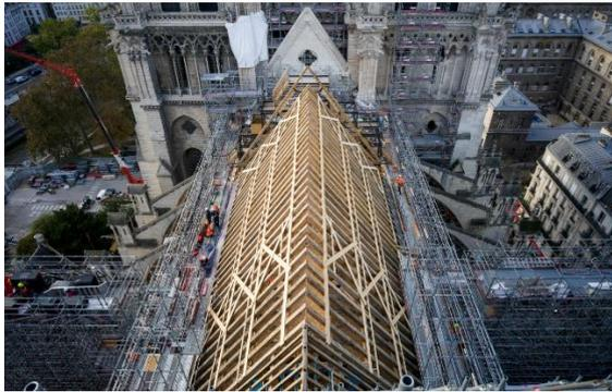
*vue partielle de la reconstruction des voûtes, de la charpente surnommée "la forêt de Notre-Dame", de la flèche et de la couverture. En novembre 2024 : la forêt vue du grand comble de la nef. Mille chênes, soigneusement sélectionnés pour leur caractéristiques et propriétés, ont été nécessaires pour réaliser ce travail titanesque.*
