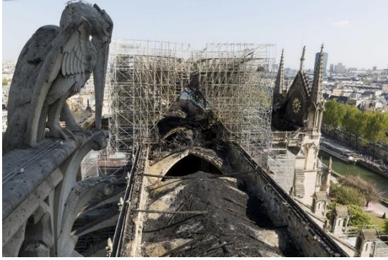
La toiture de la cathédrale Notre-Dame de Paris après l'incendie © ALEXIS KOMENDA / C2RMF /
